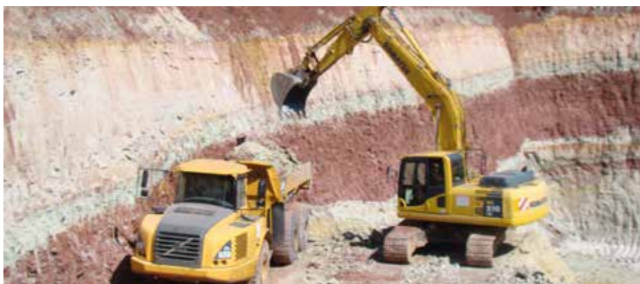
Les équipements lourds extraient la roche blanche de la carrière afin d'en dégager un sable utilisé comme composant pour le ciment.
