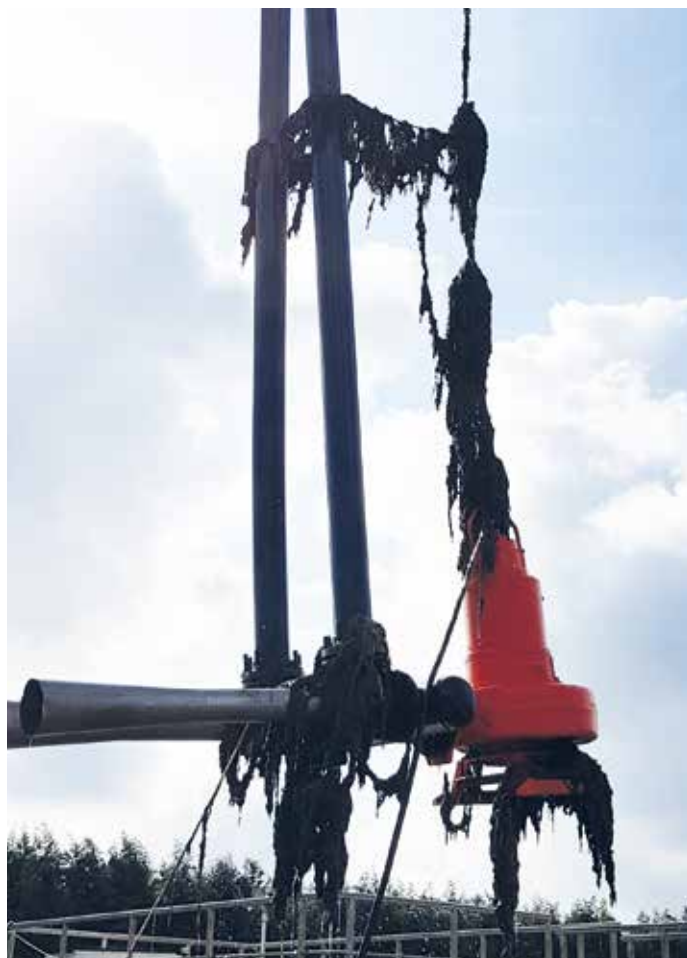
Maintenance d'une pompe obstruée par des lingettes.
