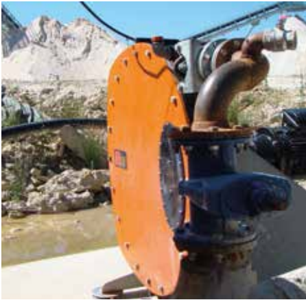
La pompe Abaque HD100 installée sur le site de Livry en 2018.
