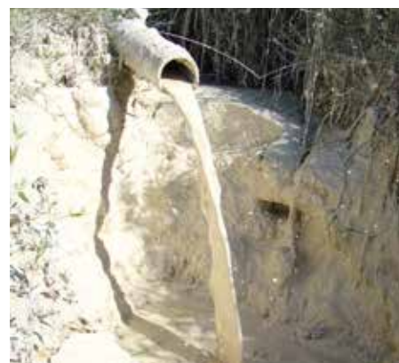
Évacuation des eaux usées dans le réservoir de rétention.
